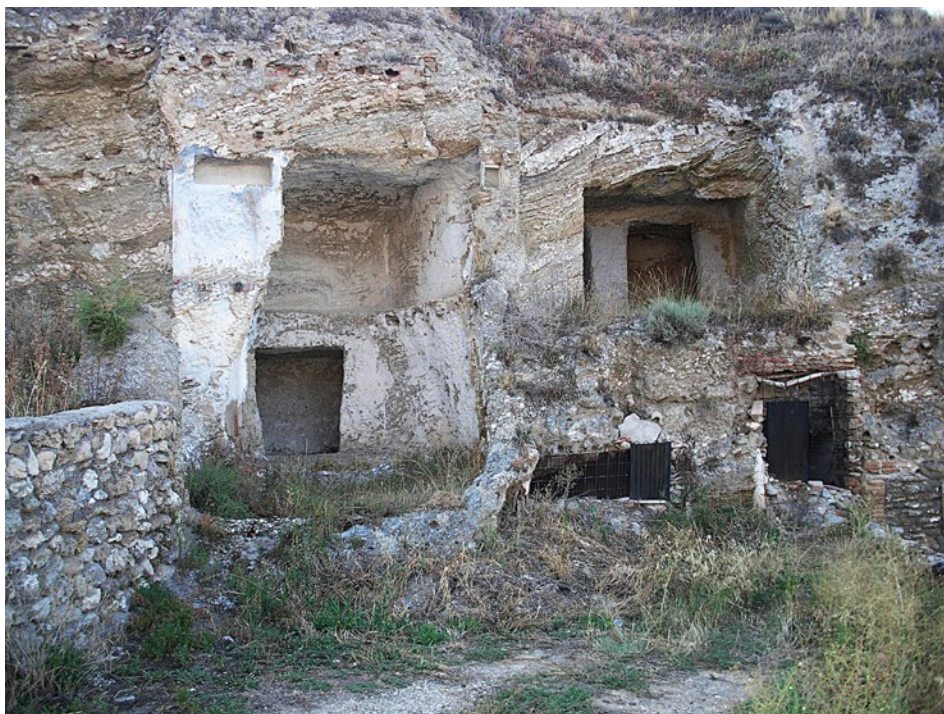
Fig.1. Barrio Picado Alto (Morería). Viviendas cueva que fueron despojadas de añadidos que pretendían mejorar las condiciones de habitabilidad. Dados los efectos negativos en el impacto ambiental dichos añadidos se eliminaron en el año 2002 de acuerdo con los planes urbanísticos de la ciudad. El cometido lo llevó a efecto el Taller de Empleo "Aljez".
