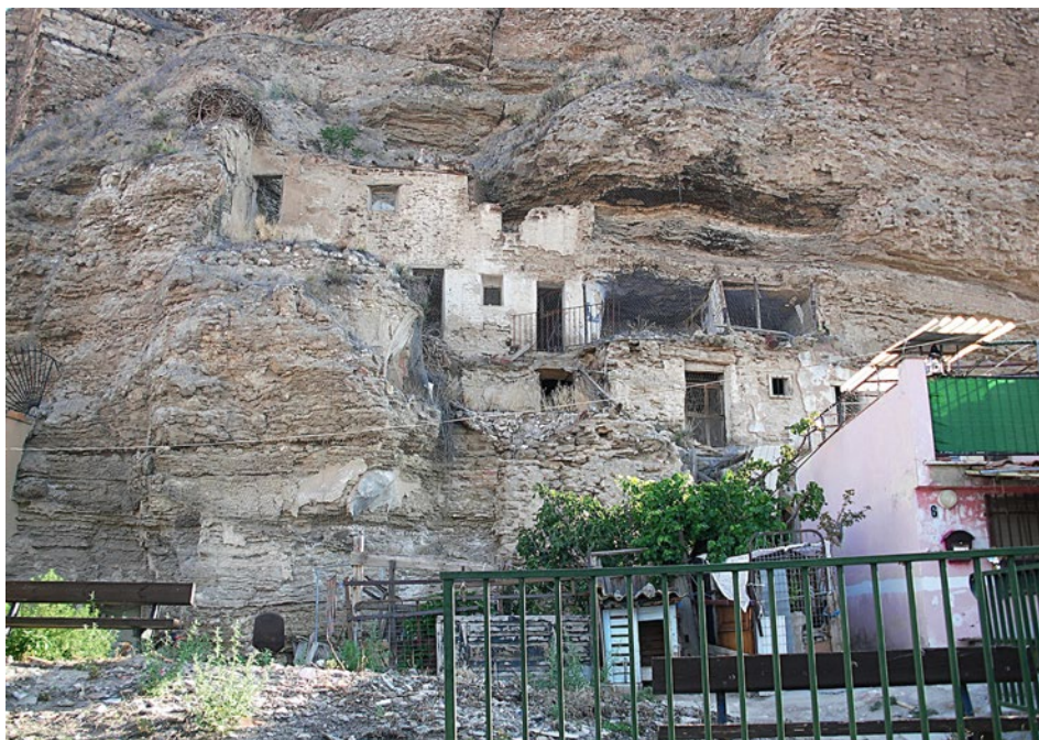
Fig.4. Cuesta de Santa Ana (Judería). Restos de fachadas por encima del nivel de calle que pretenden integrarse en el conjunto urbano y que esconden cuevas originales. (Rincón de la Perina).
