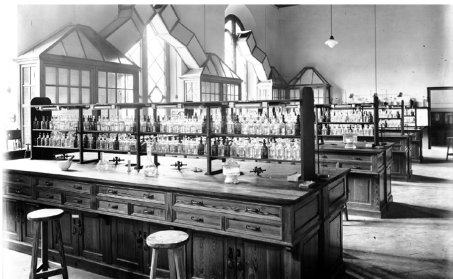
Fig. 4. Nuevos laboratorios de Química Inorgánica y Química Analítica de la Facultad de Ciencias de la Universidad de Barcelona.
