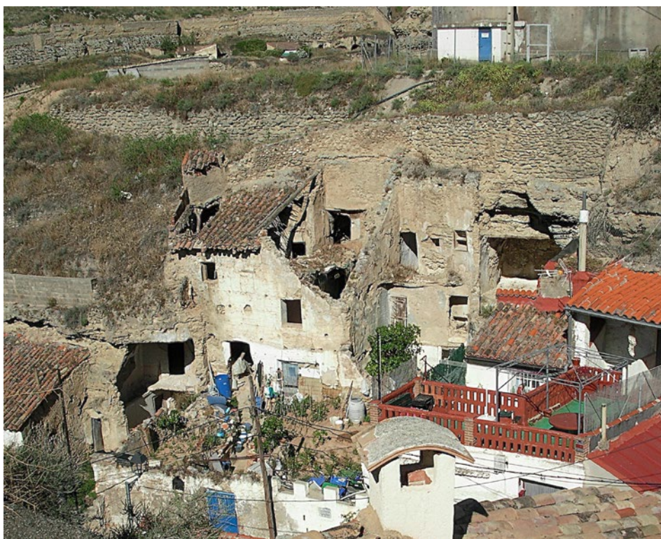
Fig. 2. Calle de La Paz (Morería). Las primitivas cuevas aparecen camufladas por maltrechas edificaciones convencionales. Se añadieron otras con el paso de los años según necesidades y cambios en los criterios constructivos y habitacionales. Se trata de algo común a todas las zonas de cuevas a las que alcanzó la evolución urbanística.
