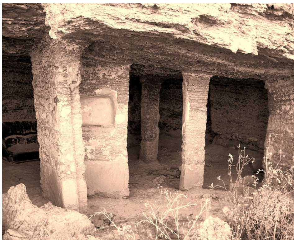
Fig.6. Extramuros de la calle Soria. Gran excavación y bien tallada con presencia de pilares de sección cuadrada sin orden preestablecido pero con idéntica función. Hoy aparece sin la pared exterior que la cerraba cuyos derrumbes quedan a pie de embocadura.
