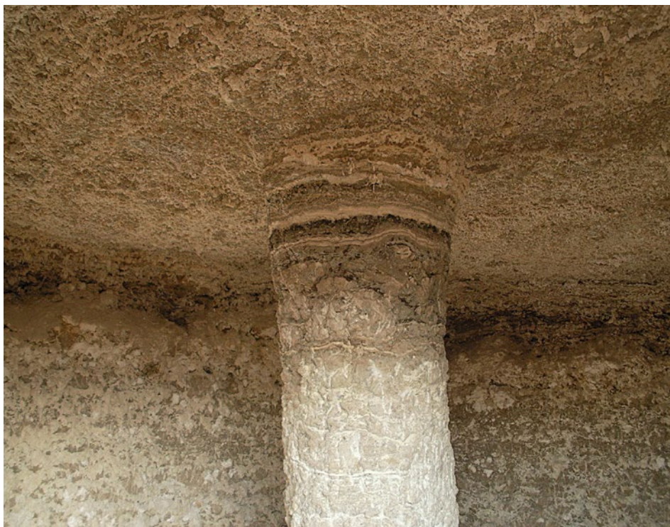
Fig.9. Extramuros de la Puerta de Zaragoza. Ejemplo singular de soporte cilíndrico perfectamente tallado y hecho uno con la roca que demuestra, a la vez, la exquisita sensibilidad de quien realizara la excavación a pesar de la indigencia del entorno en que se ubica.
