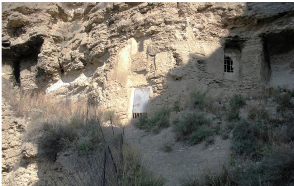
Fig.3. Consolación Alto (Judería). Viviendas cueva que no fueron enmascaradas por construcciones posteriores al quedar en un nivel por encima del trazado de la calle. En las fachadas se combina la roca natural con mampostería de piedra a veces, otras de adobe.
