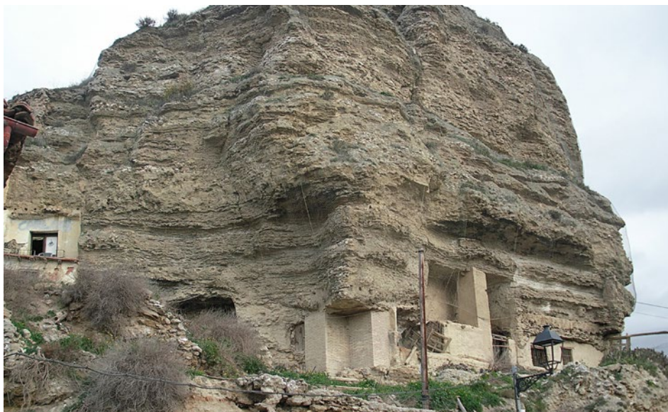
Fig.5. Barrio Mozárabe. (Cara sureste del Castillo del Reloj). Conjunto de cuevas y fachadas convencionales entre soportes que sustentan el saledizo de la roca. Quedan, en varios tramos, orificios en los que apoyaban los maderos horizontales de techumbres exteriores añadidas.
