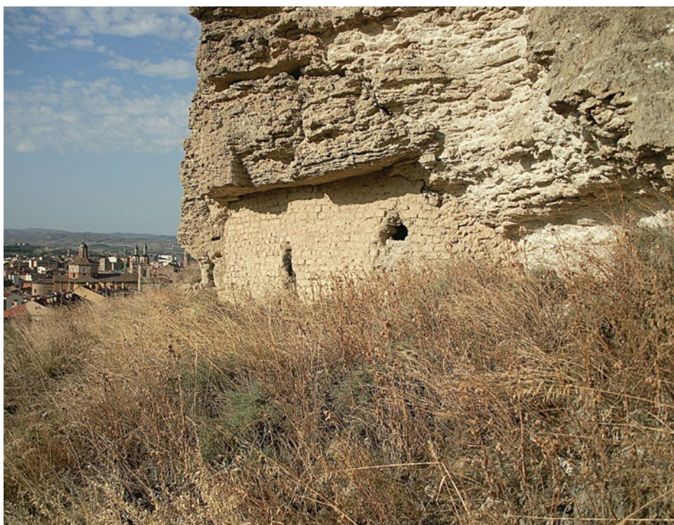
Fig.10. Extramuros de la Puerta de Zaragoza. Cueva en lo más enristado del monte. La pared exterior es de adobe asentado con argamasa de aljez y arena.
