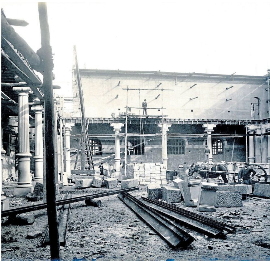
Obras en el patio del Museo de Zaragoza, en la Nochevieja de 1907.
