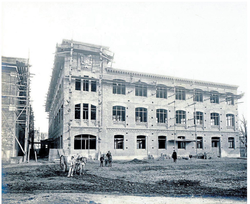
Construcción del edificio de La Caridad, en 31 de diciembre de 1907.
