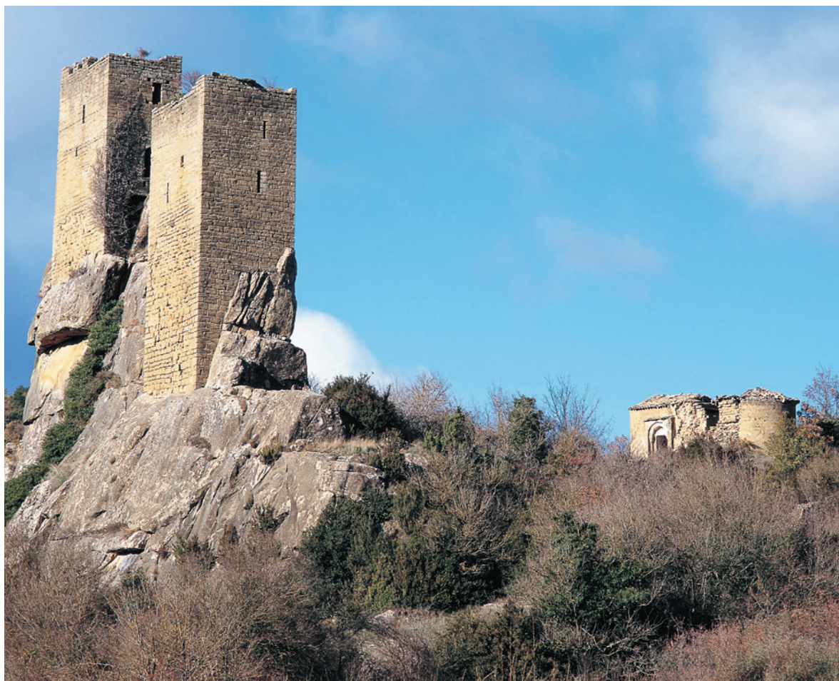
Las torres de Sibirana sobre el promontorio rocoso. A la derecha, la ermita de Santa Quiteria. Foto cedida por la Comarca de las Cinco Villas.
