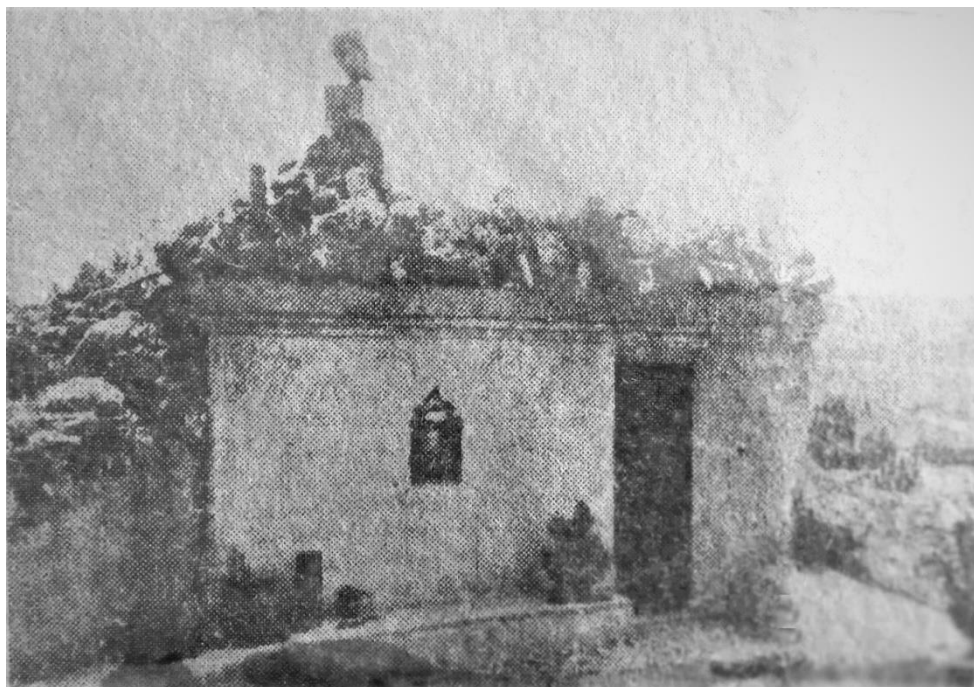
Fig. 19: Inicio de la construcción del monumento a Costa sobre el gabinete, en la parte más elevada de la finca. Hacia 1935.
