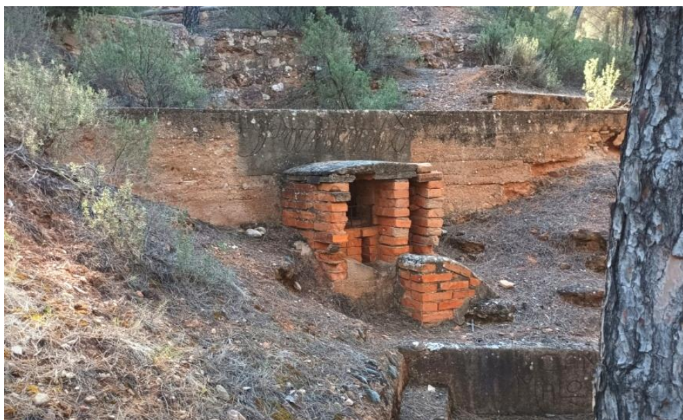
Fig. 25: Muros de contención del pantano y pequeña edificación para la llave de salida del agua.
