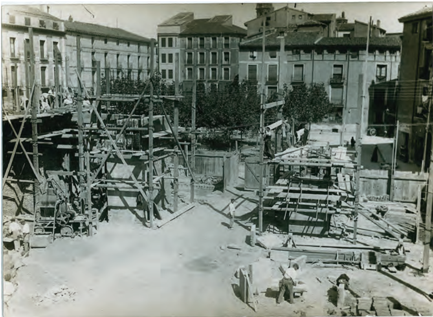
FIG. 2. Inicio de los trabajos de construcción de los pilares de la iglesia; el espacio arbolado se corresponde con la plaza de San Lorenzo. Marín Chivite (1930).
