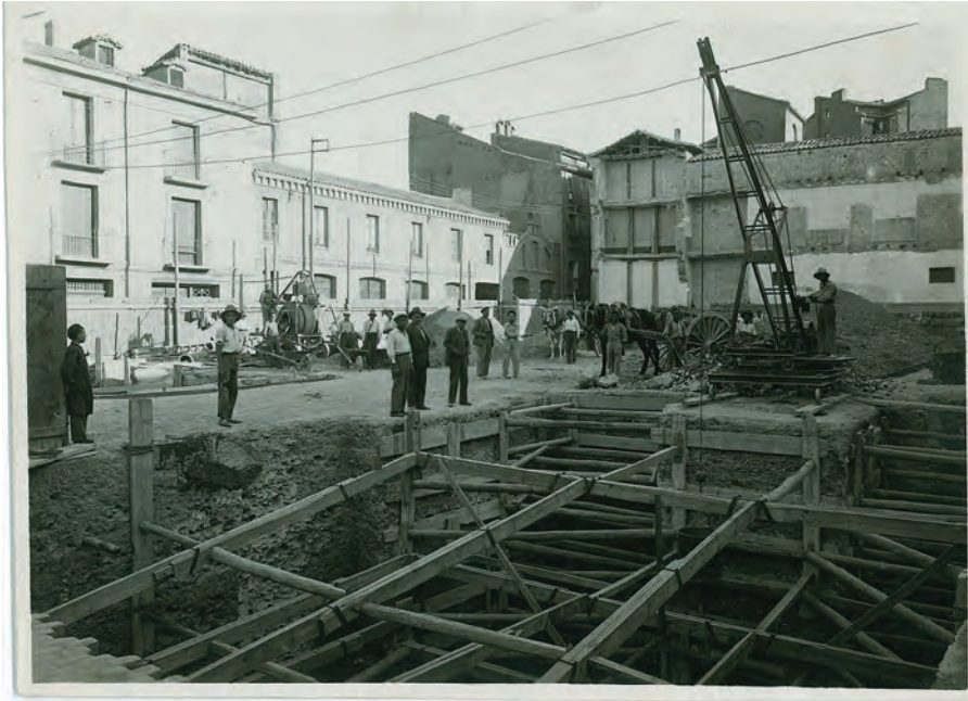
FIG. 1. Trabajos de cimentación del nuevo templo del Sagrado Corazón. Marín Chivite (1930).
