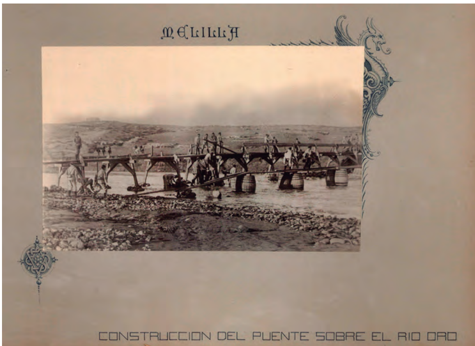
FIG. 1. Manuel Compañy. Construcción del puente sobre el río Oro. Álbum de la guerra de Melilla, 1893. Archivo de Palacio. Patrimonio Nacional.
