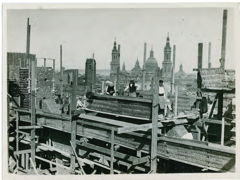
FIG. 3. Grupo de obreros trabajando en el remate de las arcadas de la fachada principal; tras ellos, la torre de la iglesia de San Juan y San Pedro y el templo del Pilar. Marín Chivite (1930-1931).
