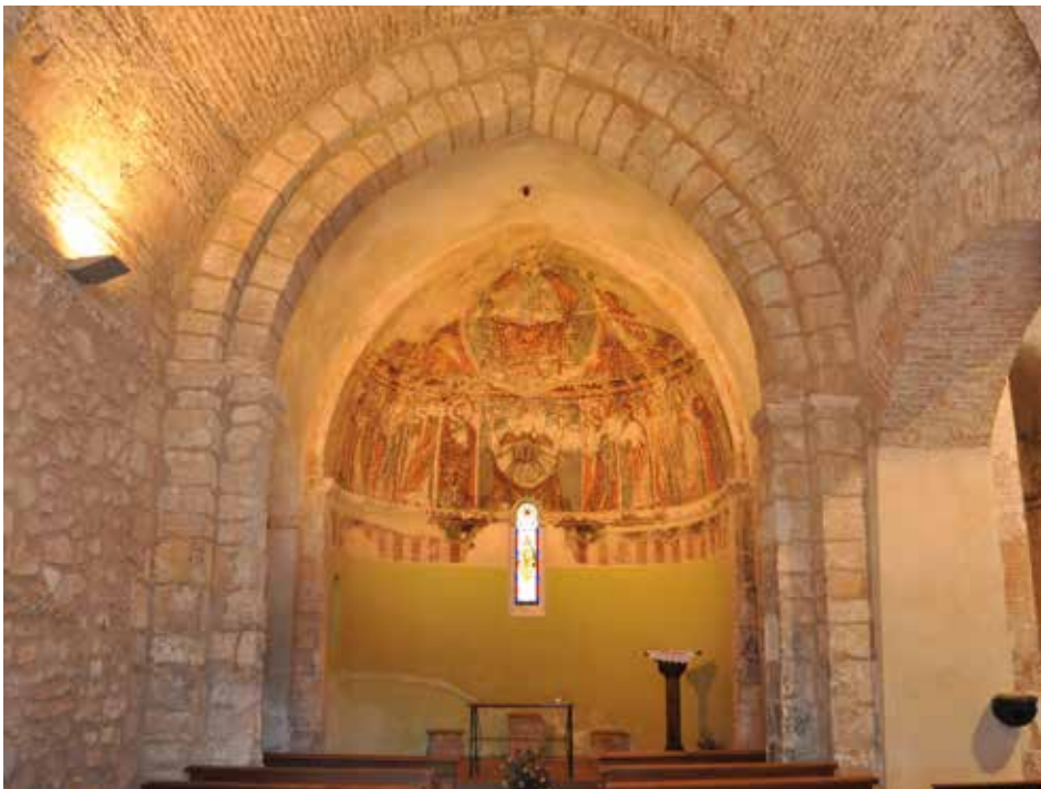
Fig. 2. La Almunia de Doña Godina, ermita de la Virgen de Cabañas, ábside. Estado previo a la intervención. Foto: DPZ.
