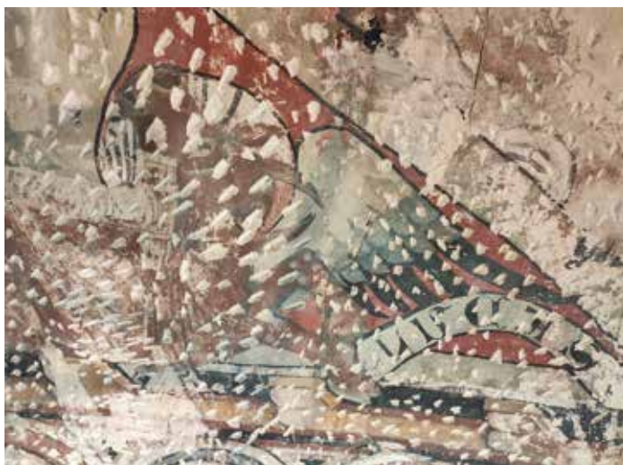
Fig. 3. La Almunia de Doña Godina, ermita de la Virgen de Cabañas, ábside. Detalle de las erosiones por repicado del muro. Foto: Albarium.
