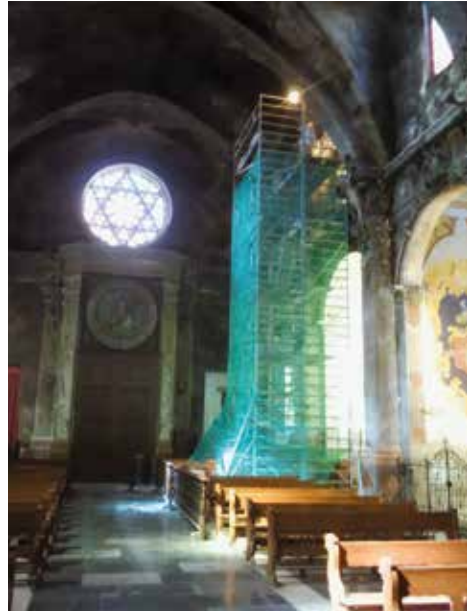
Foto 5. Fotos del andamio de los estudios previos.
