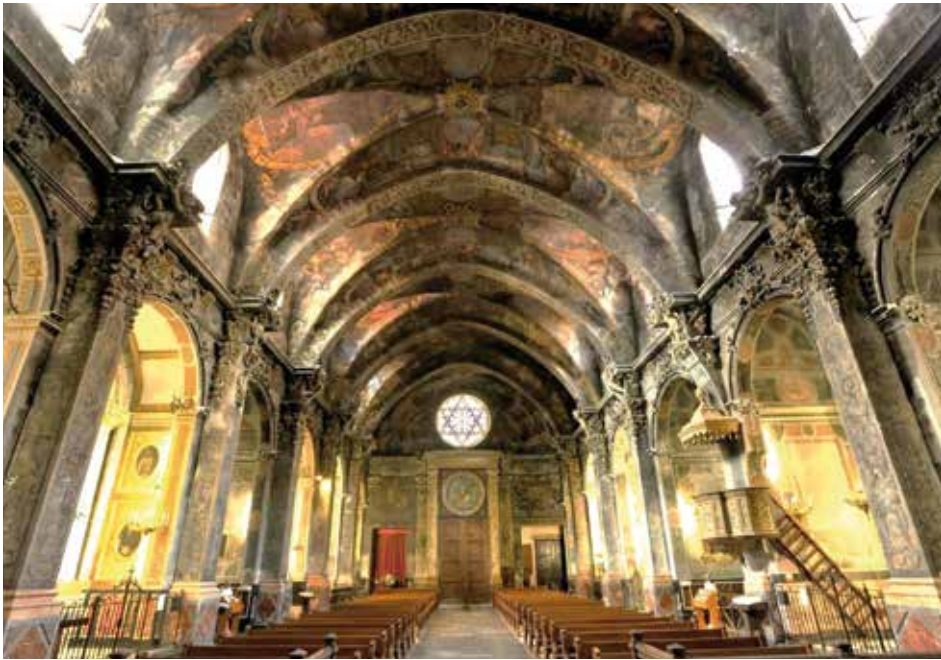
Fig. 2. Interior antes de la restauración.
