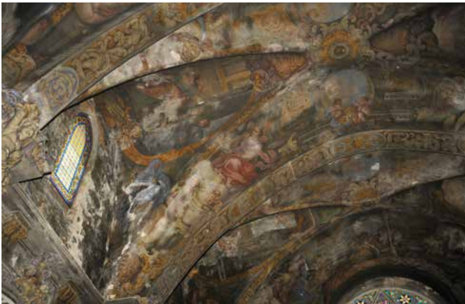
Fig. 3. Vista interior antes de la restauración.
