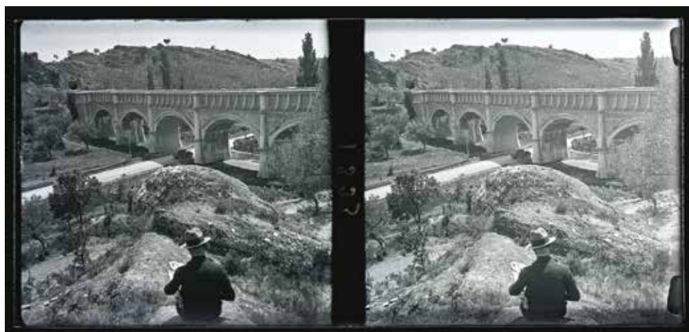
FIG. 4. Acueducto de Perera del Canal de Aragón y Cataluña (Huesca). Abril 1929 (ACHE 1333).
