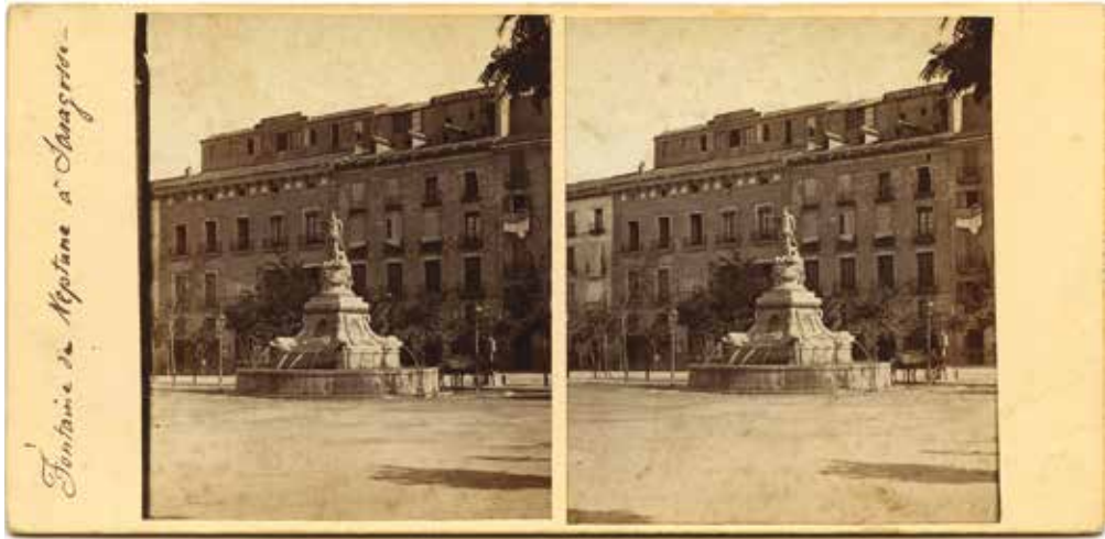
FIG. 2. Plaza de la Constitución y vista de los estudios de Júdez y Álvarez. Mariano Júdez, ca. 1864. Colección Francisco Palá, Madrid.
