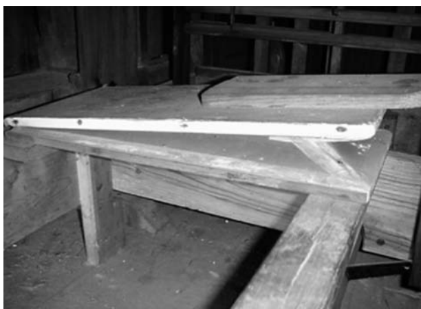
Fig. 13. Fuelle para suavizar el cierre de las persianas.
