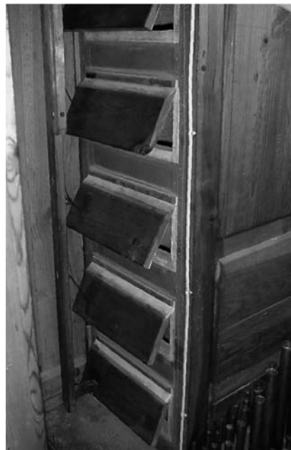
Figs. 11 y 12. Una de las cajas expresivas del órgano de San Pedro Apóstol de Beizama (Roqués, 1862), con las persianas laterales en posición horizontal, cerradas y abiertas.
