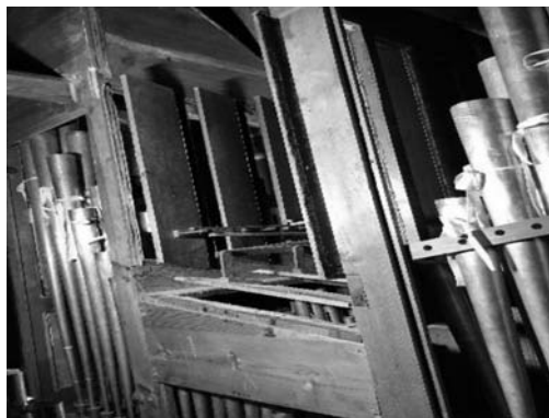
Figs. 14, 15 y 16. Caja expresiva del órgano de San Miguel Arcángel de Larraga (Inchaurre y Puyó, 1878). La apertura se realiza en la zona central más baja. A los lados, las torres para alojar los tubos más graves, con los paneles desmontados para el mantenimiento. Estos paneles son fijos.
