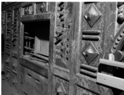
Fig. 4. Vista de la consola. Bajo el teclado, la tabla sin policromar que oculta el recorte para el \frac{1}{2} teclado de ecos. Diferentes perforaciones para los alojamientos de registros.
