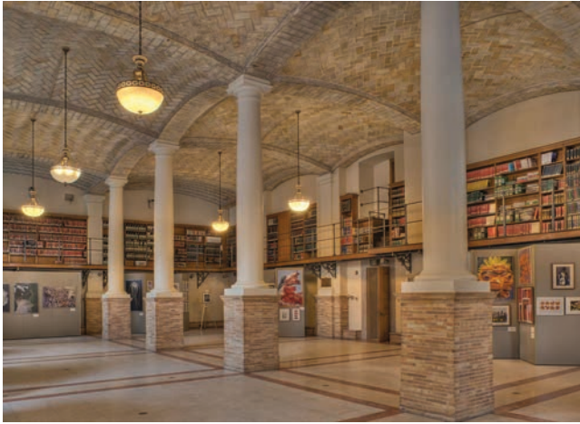
Lám. 146. Bóvedas tabicadas en la Sala del Catálogo de la Biblioteca Pública de Boston. Massachusetts, EEUU. 8 de abril de 1889. Arquitectos: Mc Kim, Mead & White. Fotógrafo: Michael Freeman.
