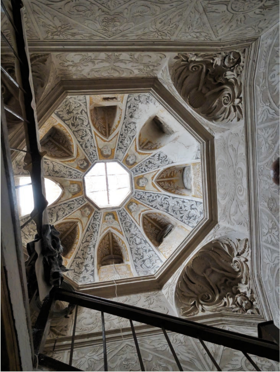
Lám. 124. Cúpula de la caja de la escalera de la casa de la Alcaidía de Carenas, siglo XVII.
