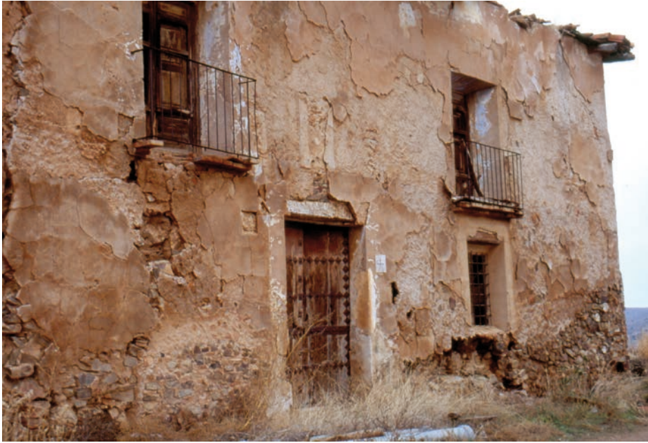
Lám. 126. Vista general de la fachada de la Granja de Zaragocilla.
