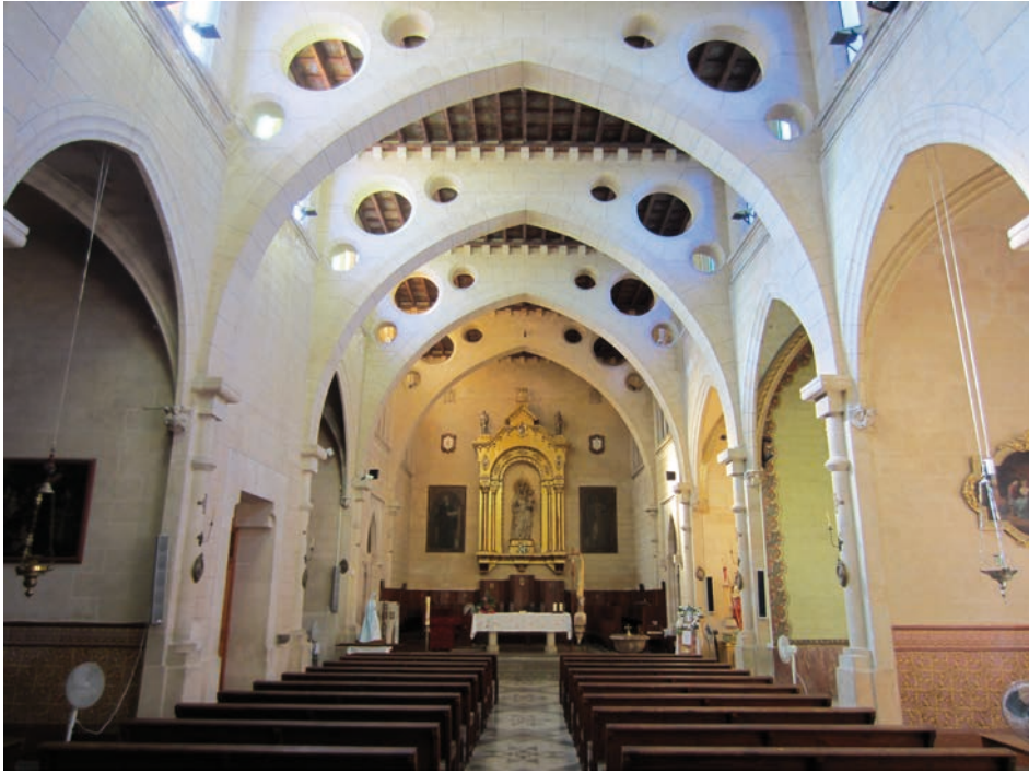
Lám. 115. Vista actual del interior de la iglesia del Monasterio de Santa María de la Real, reconstruida a comienzos del siglo XX.
