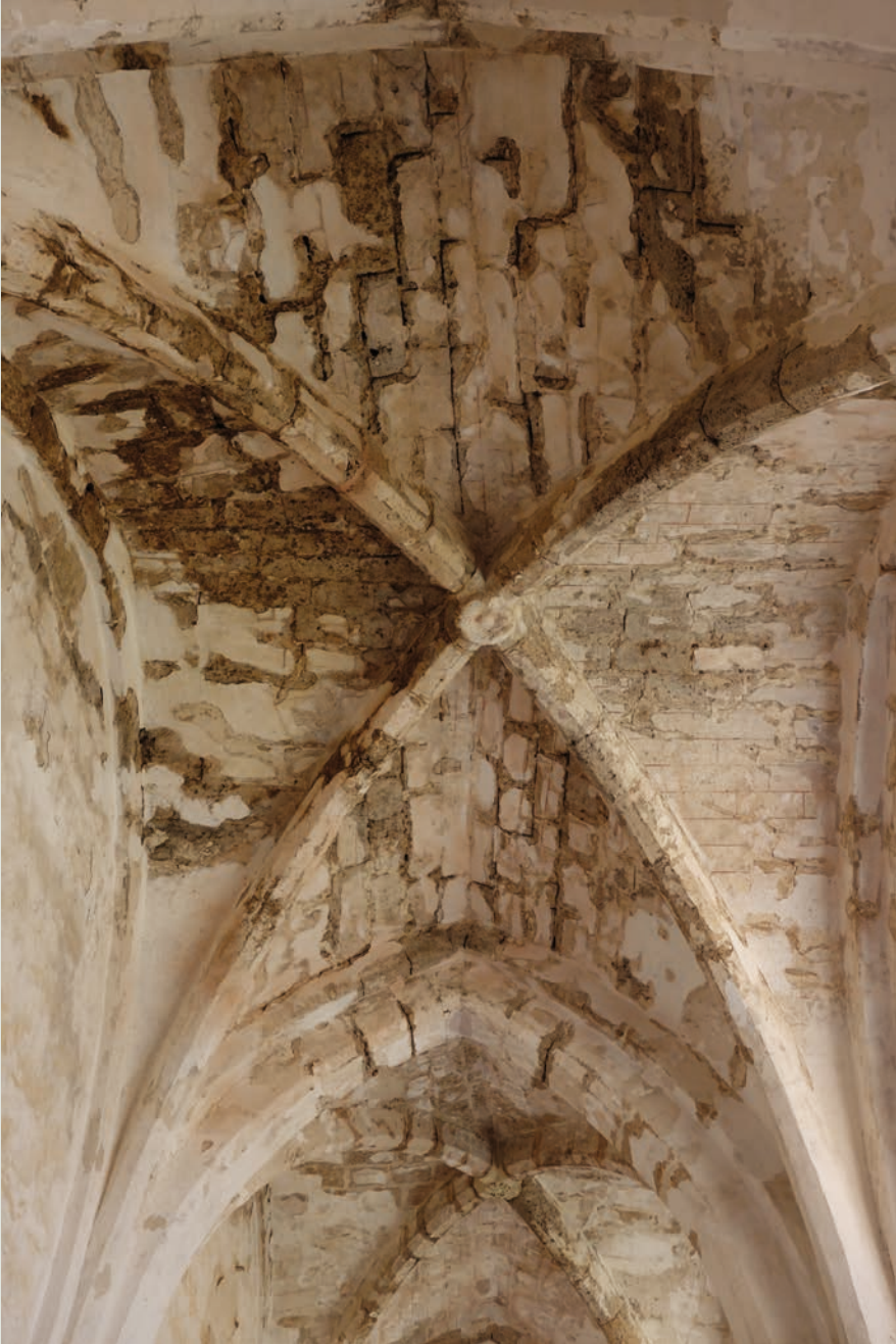
Lám. 104. Bóvedas de crucería y plementerías de la nave lateral de la iglesia abacial de Santa María de Piedra, s. XIII.
