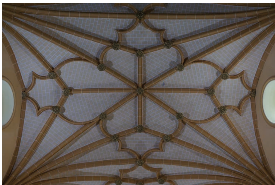
Lám. 88a y 88b. Comparativa del desarrollo de los sistemas de abovedamiento ideados para cubrir la antigua enfermería de Piedra, hoy escalera monumental (a) y las bóvedas construidas por Martín de Miteza para cubrir la iglesia de Santa María de Trasobares (b), 1565.
