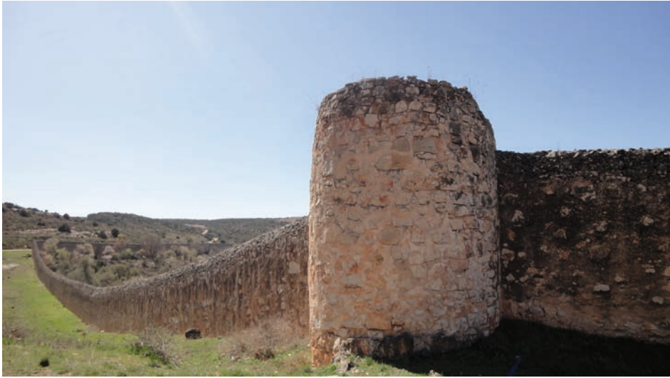
Lám. 67. Cerca amurallada del siglo XVII jalonada de torreones cubo para mantener el control de la visibilidad y dar la máxima protección al Monasterio de Piedra.
