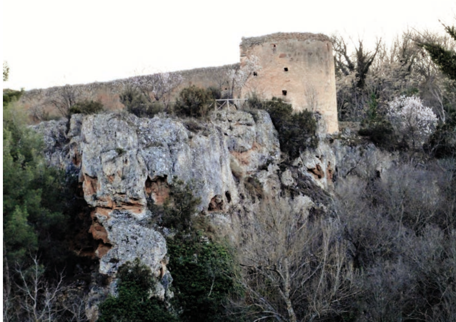
Lám. 68. Torre usada como ermita, situada en el sector meridional de la muralla de Piedra, junto al barranco donde se cierra el recinto fortificado.
