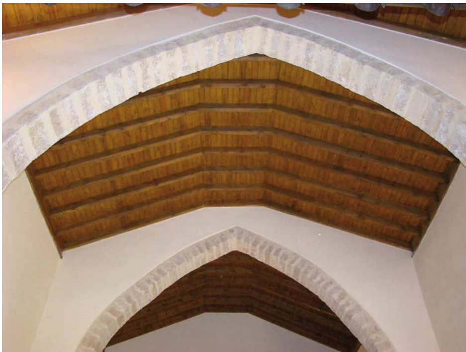
Lám. 50. Arcos diafragma en la nave de la iglesia de Henche, Guadalajara. Principios del siglo XIII.
