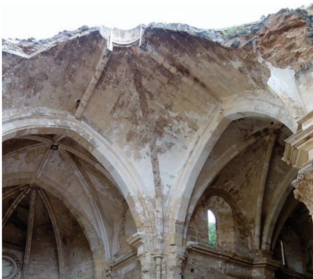
Lám. 34. Sistema de abovedamiento de la iglesia abacial de Piedra en el siglo XIII a base de bóvedas autoportantes con plementos y nervios independientes, nervio en ligazón central y óculo horadando uno de los plementos del ábside.
