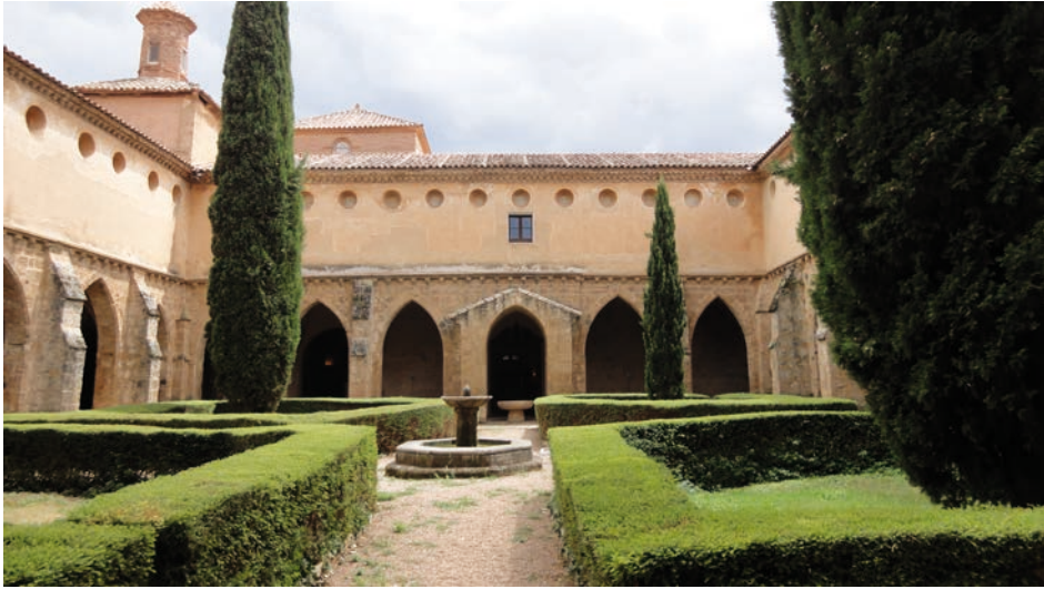
Lám. 38. Claustro del Monasterio de Piedra, organizado como un jardín crucero con fases constructivas, el claustro bajo, edificado en el siglo XIII, y el claustro alto del siglo XV.
