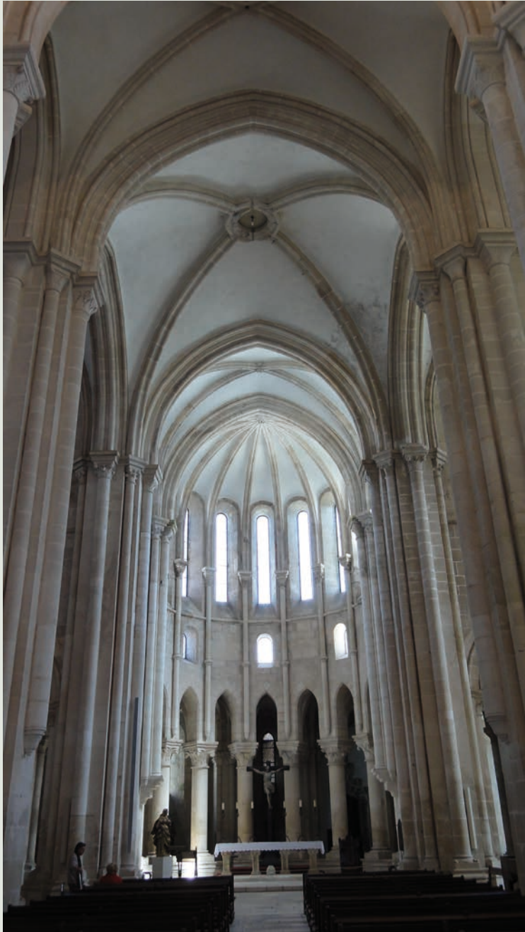
Lám. 21. Vista general de la nave central y la cabecera de la iglesia de Alcobaça, abadía fundada en 1148 y consagrada en 1222.
