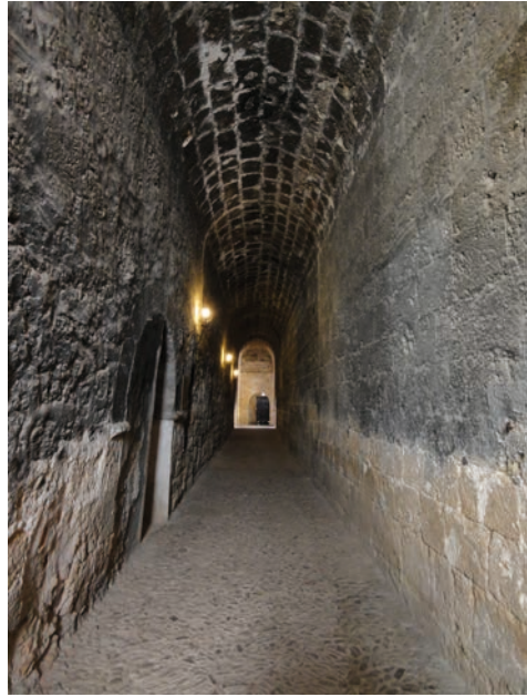
Lám. 2. Pasillo de los hermanos legos conversos del Monasterio de Piedra cubierto con una bóveda de cañón corrido, s. XII.
