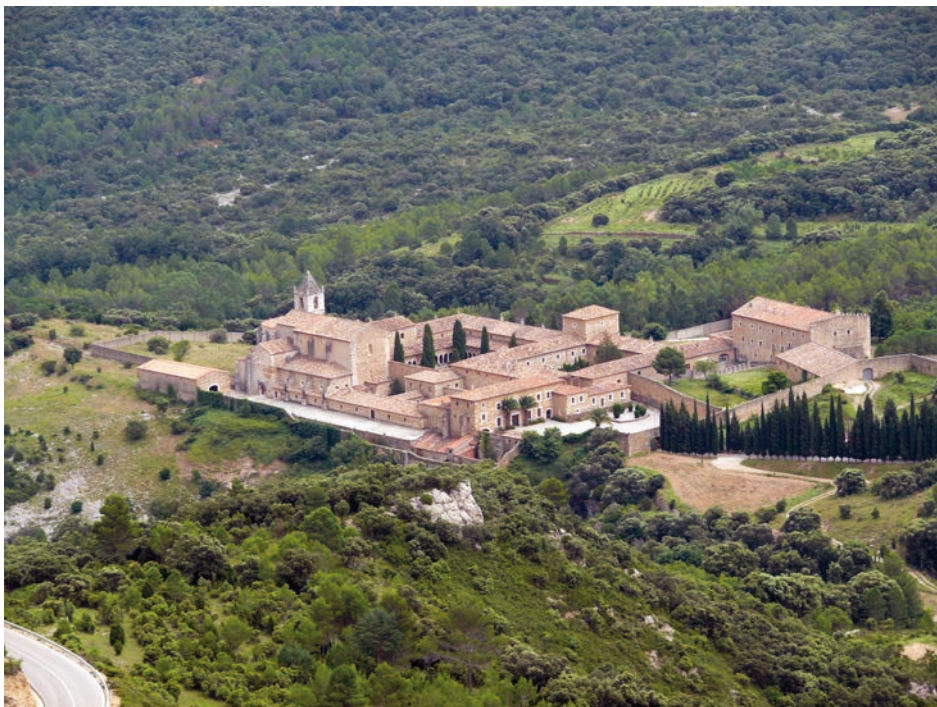
Lám. 5. Vista general del Monasterio de Benifassá, fundado en 1233 por orden de Jaime I.
