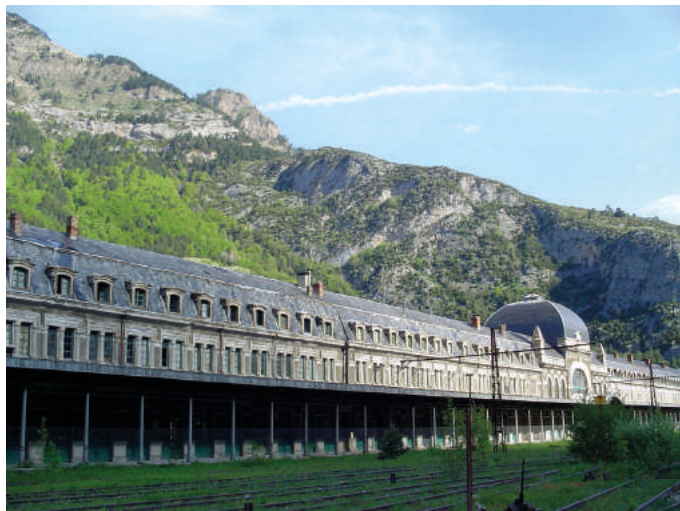
Fig. 1: Fotografía David Ibáñez, Vista del andén francés de la estación de Canfranc, 2004, colección particular.
