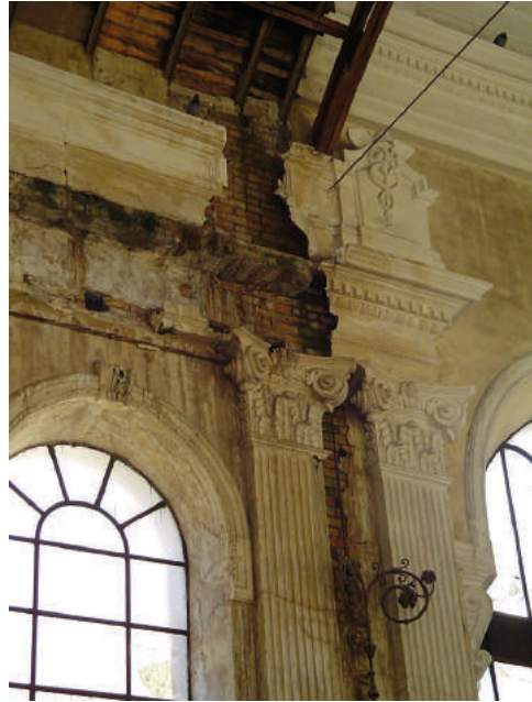
Fig. 3: Fotografía David Ibáñez, Decoración interior del vestíbulo la estación de Canfranc, 2005, colección particular. En la imagen se aprecian los relieves alegóricos a Mercurio.
