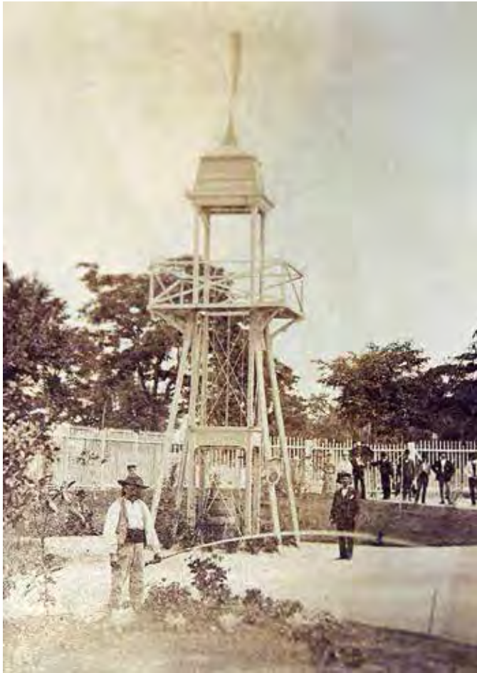
Montacargas del expositor «Merly Sevilla», de Madrid, en el exterior del palacio de exposiciones (Bodegas Toro Albalá, Aguilar de la Frontera, Córdoba).
