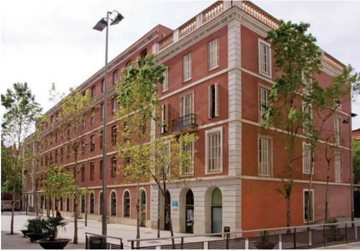
Figura 3. Alzado principal del Vapor Vell. Foto de Carlos Colás.
