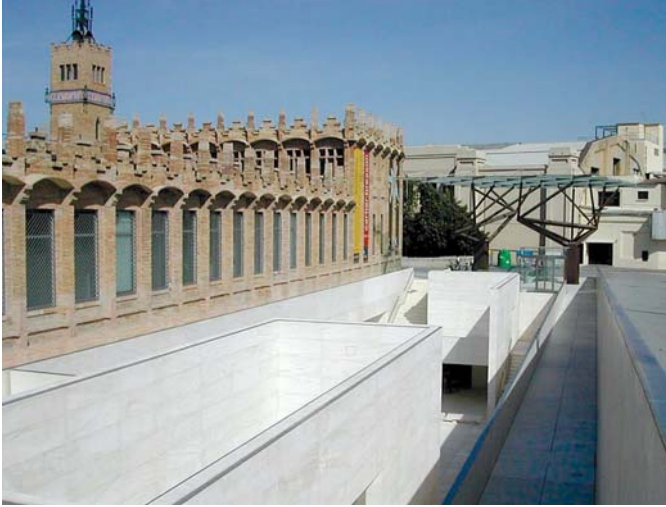
Figura 4. Alzado principal de CaixaForum Barcelona. Foto Ascensión Hernández.
