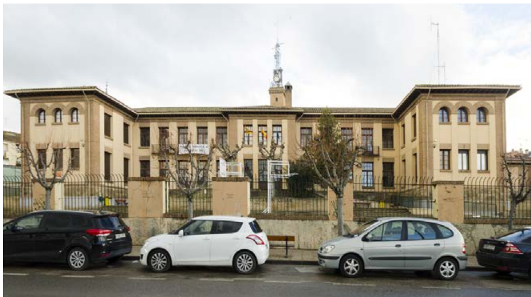
10. Aspecto actual de la fachada principal del grupo escolar Joaquín Costa. Fotografía Rafael Lapuente.
