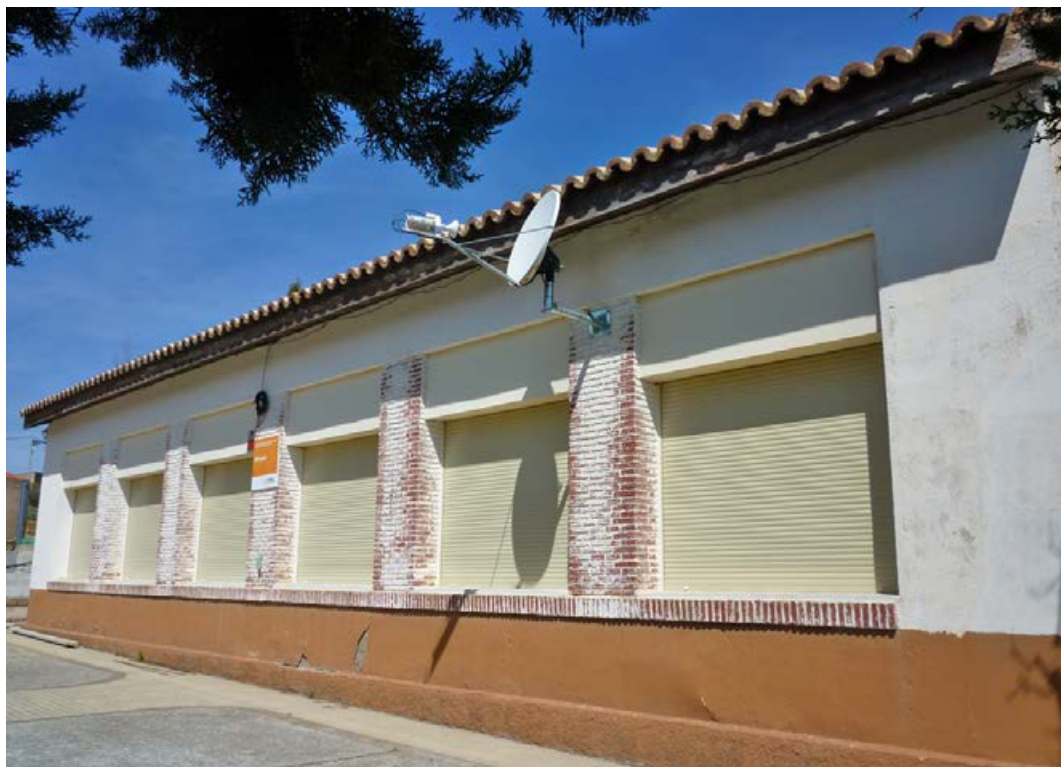
13. Fachada principal de las escuelas unitarias (luego Centro Rural Agrupado Bécquer) de Añón de Moncayo (Zaragoza). Fotografía autora.
