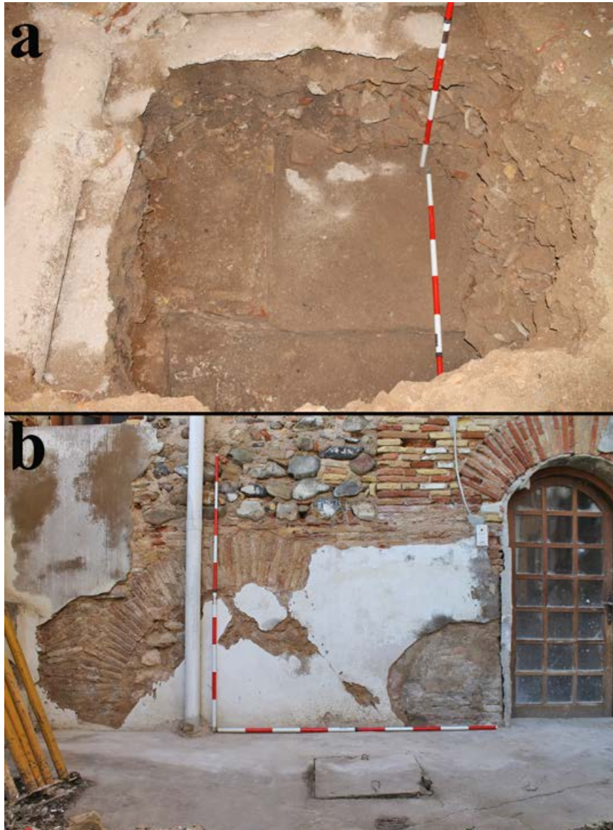
6. Sondeo 3: a. Vista del sondeo. b. Arcos vistos desde el exterior.
