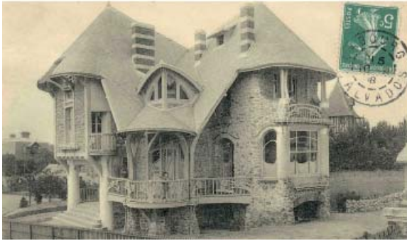
Fig. 3: Villa «La Surprise», en Cabourg, en Calvados, en la costa de Normandía, construida por Guimard en 1903 y ampliada en 1907.
