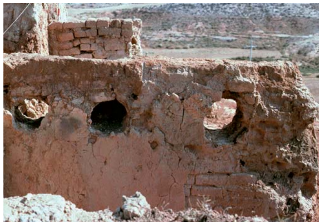
fig. 5. Edificio de adobe en el momento de su excavación.
