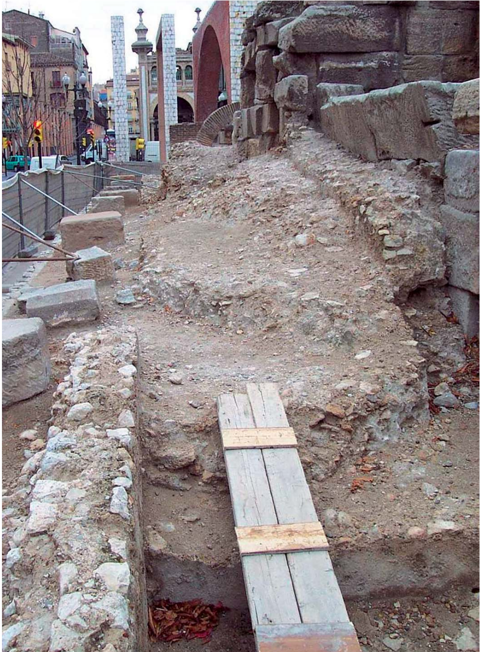
fig. 8. Muralla de San Juan de los Panetes, donde se ha conservado el muro delantero de hormigón [H2]: derecha y arriba, junto a la sillería. La sillería monta sobre la parte conservada del muro. A la izquierda se encuentra el muro trasero [H3], entre ambos el relleno [H5] y delante el muro transversal [H4], apreciable por el frente liso.
