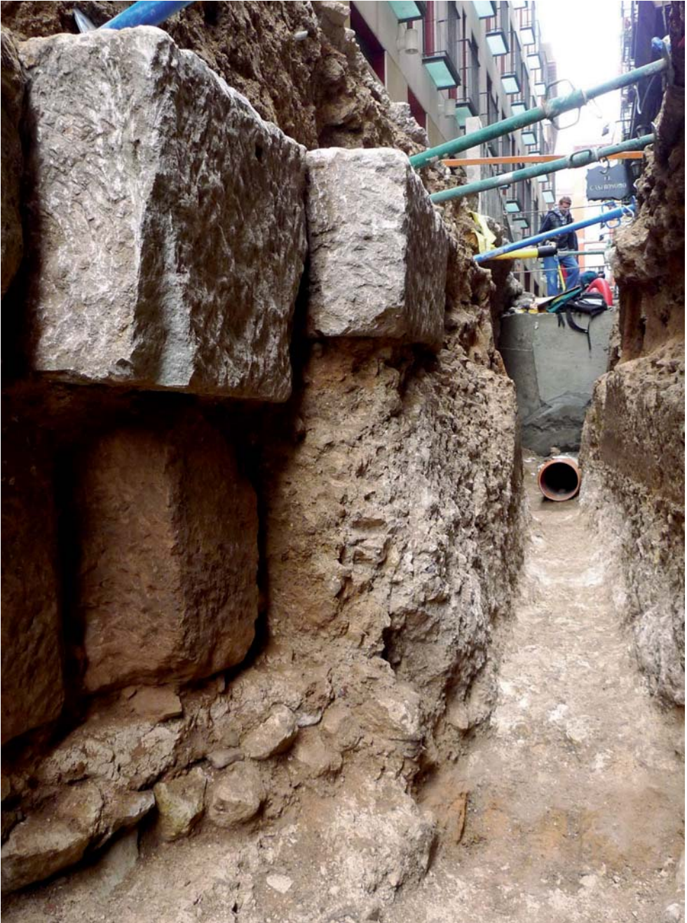
fig. 3. Corte oeste desde el sur. La sillería escalonada delante del hormigón. El piso de la zanja forma parte de las cimentaciones una vez cortadas por obras anteriores. La parte más angosta corresponde al canal que atravesaba la plataforma de hormigón [H1]. Su base estaba a la altura de la línea que marca una diferencia de texturas: lisa (pared del canal), rugosa (cimentación cortada).
