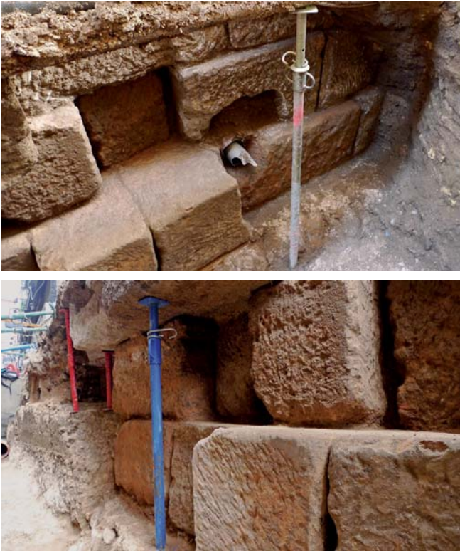
fig. 5. Corte este desde el noroeste. El tubo que perfora uno de los sillares marca el límite entre la parte que corresponde al lienzo (izquierda) y el arranque de la torre (derecha). Puede verse cómo los sillares del lienzo y la torre se compenetran.
