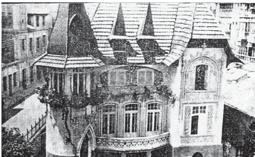
Fig. 8. La casa de las Brujas o de las Hadas, calle de Gil de Jasa núm. 24, esquina a Alar del Rey, durante años sede del Colegio Santo Tomás de Aquino (desaparecido), Zaragoza. Foto: < http://www.rafaelcastillejo.com/zaragoza >.
