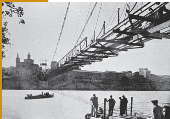
Pasarela peatonal en construcción y la barca del Tío Toni
