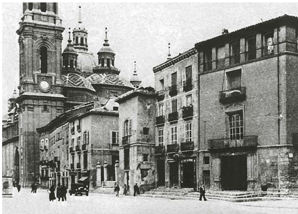
fig. 6. Vista de la fachada principal a la calle del Pilar de la casa del Marqués de Ayerbe. La fotografía está tomada una vez que había sido derribado ya el lado de los pases de la misma calle y había de procederse a su demolición en fechas inmediatas.
