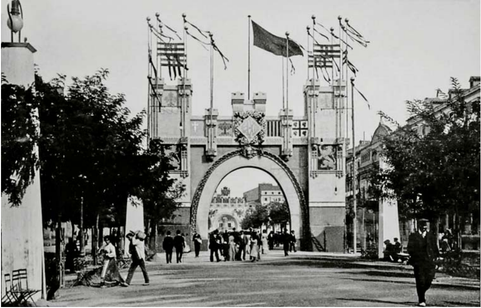
fig. 1. Arco erigido con motivo de la visita del rey Alfonso XIII a Zaragoza en 1903, y patrocinado por el Ayuntamiento, obra del arquitecto municipal Ricardo Magdalena, como arquitectura efímera, con su aspecto neomedieval y su luz diseñada a partir de una curva catenaria, al modo gaudiniano (fot. Agustín Lorente Bernal).
