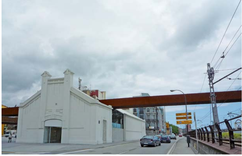
fig. 2. Edificio de la antigua Pescadería atravesado por la pasarela de acero corten que comunica la ciudad con el Centro Niemeyer.
