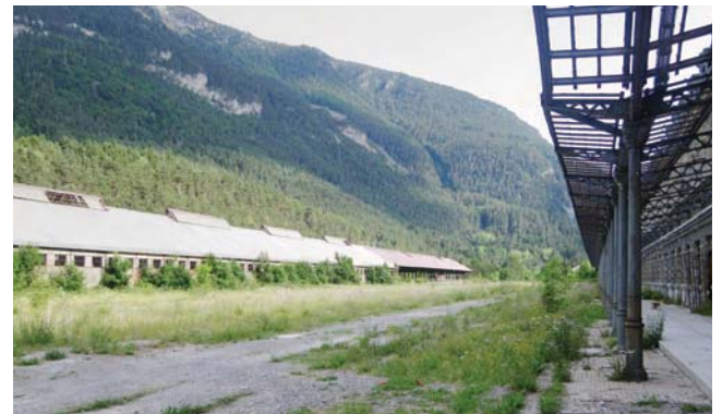
Figuras 2 y 3. Estación Internacional y edificios longitudinales del complejo ferroviario de Canfranc.
