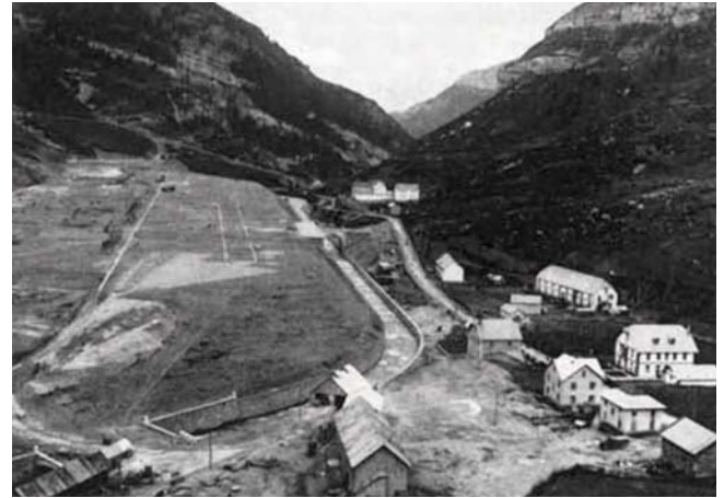
La plataforma de la estación y el desvío del río Aragón que hace posible su existencia
