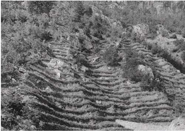
Sistemas defensivos extensivos, previos a la reforestación, para controlar las avenidas
