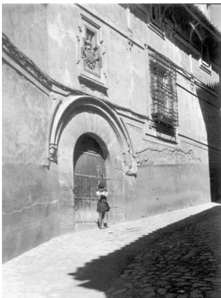
Fachada principal de la casa de la calle Azagra antes de la reforma (Archivo López Segura).
