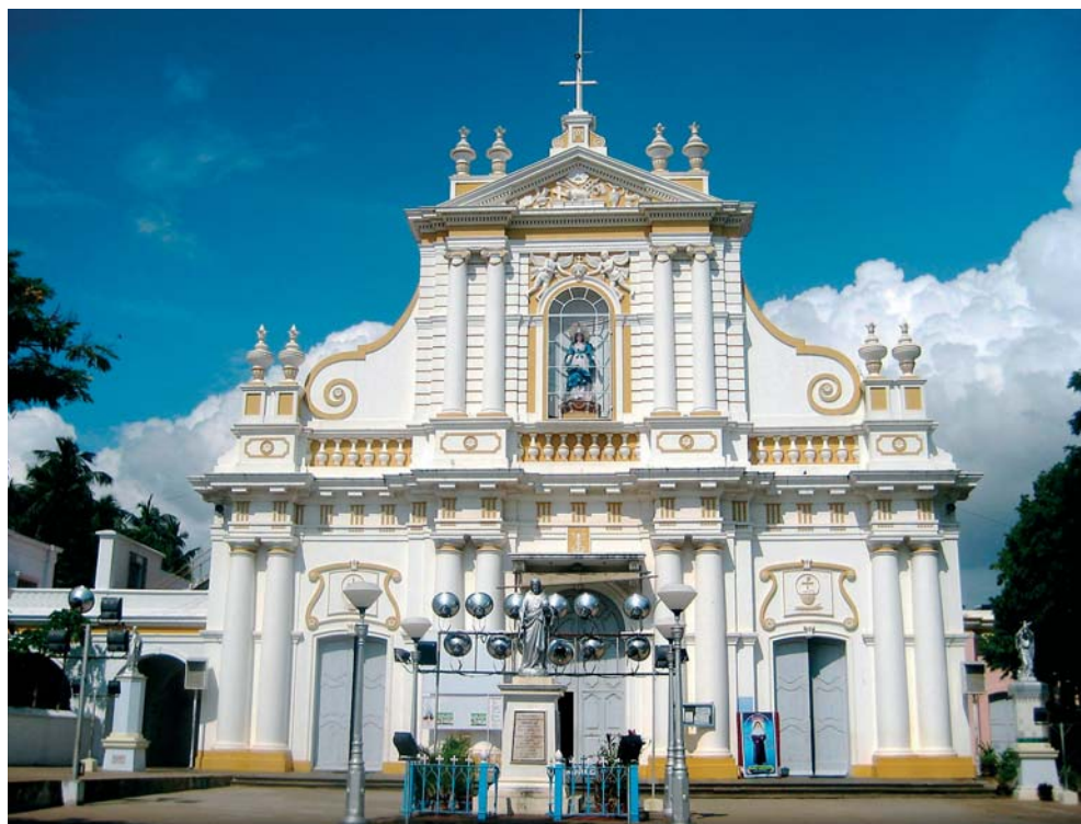
Fig. 5b. Fachada de la Catedral de Pondicherry en su estado actual.
