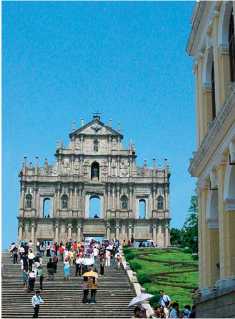
Fig. 4. Fachada de San Pablo (Macao) en su estado actual.
