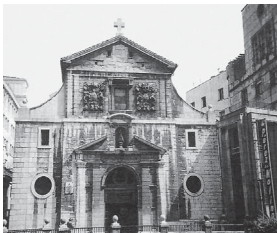
Fig. 3. Fachada de la Iglesia de Santander.
