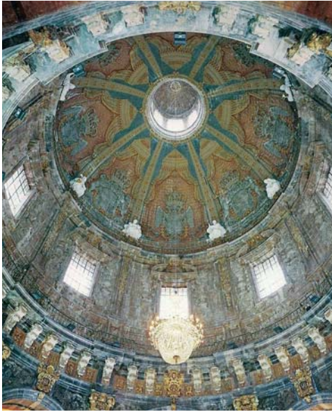
Fig. 14. Interior de la cúpula de Loyola.
