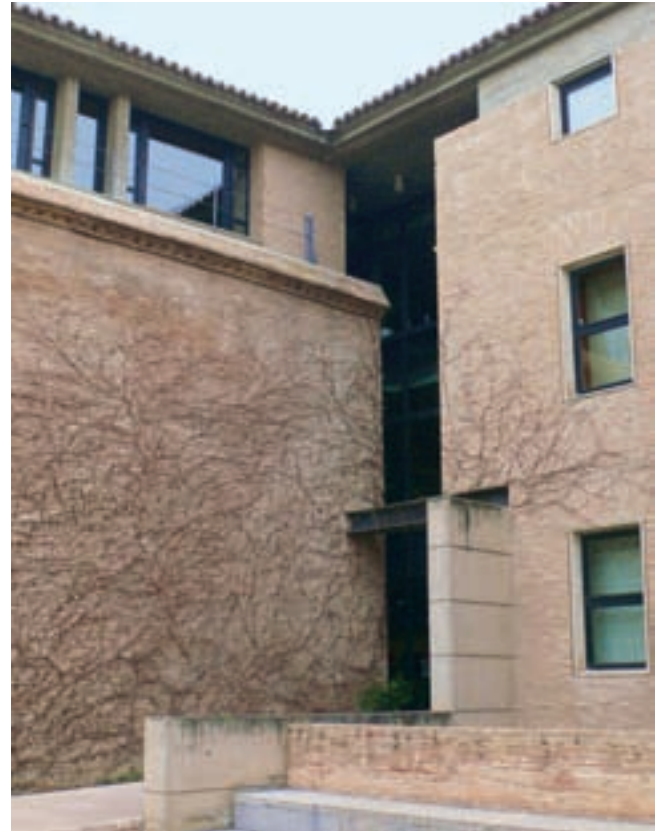
La Aljafería, detalle del encuentro entre el lienzo oeste de la muralla y el cuartel, abierto en la intervención para producir una articulación entre ambos y dar acceso a las dependencias de los grupos parlamentarios
