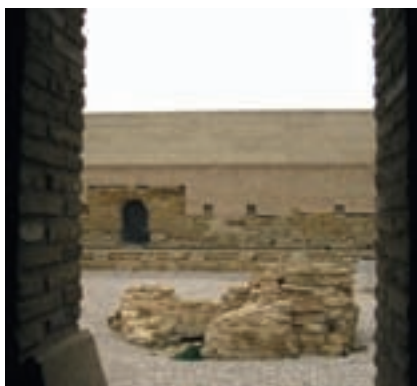
Monasterio de Sijena, vista del fondo oeste de la nave norte después de la intervención, con el cierre realizado con un nuevo tapial de hormigón
