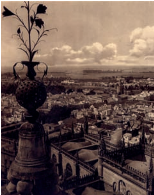
Kurt Hielscher, lámina Vista general, tomada desde la Giralda , Sevilla, 1914
