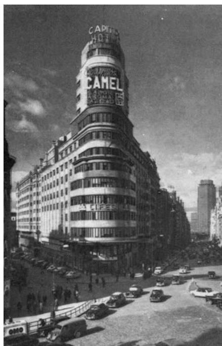
Vicente Eced y Luis Martínez Feduchi: Edificio Capitol, Madrid, 1931 (Fuente: Arquitectura Española Contemporánea )
