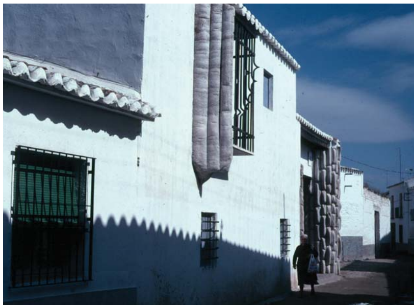
Vaquería adaptada como vivienda. Miguel Fisac en Almagro (Ciudad Real)
