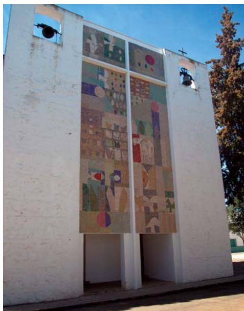
Fachada de la iglesia de Villalba de Calatrava (Ciudad Real)
