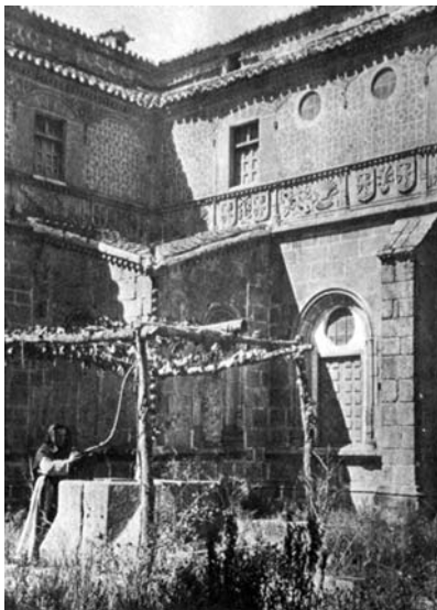
Claustro de Santo Tomás de Ávila antes de su restauración. GÓMEZ-MORENO, M.: Catálogo Monumental de la Provincia de Ávila , 2002
