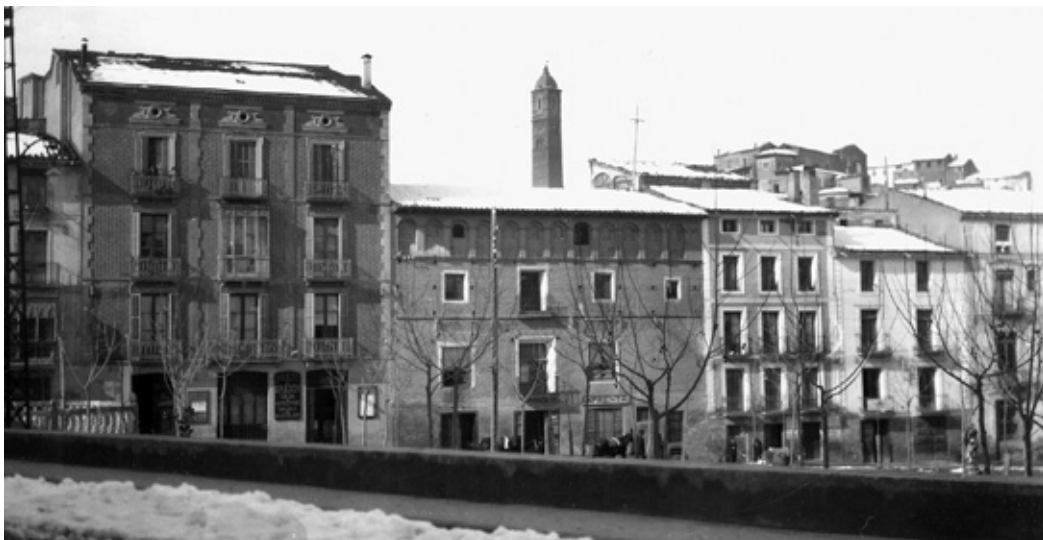
2. Imagen antigua de la fachada del edificio, en la parte izquierda de la fotografía. Foto Archivo CET.
