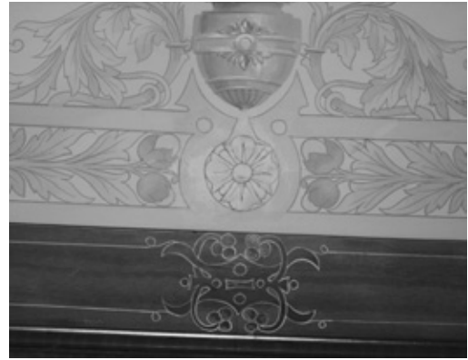
14. Proceso de restauración de la pintura mural de la habitación 3.
