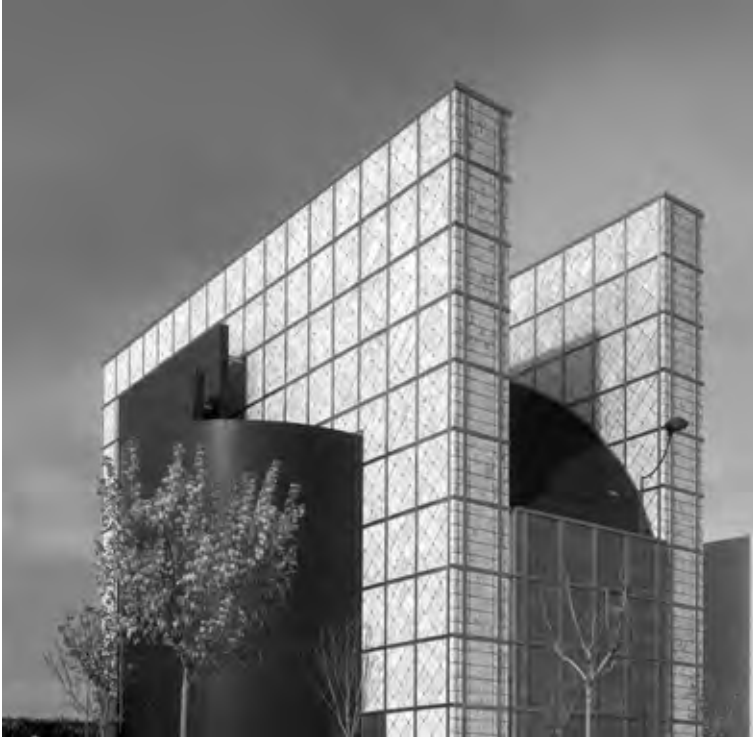
Figura 4. Vista general del edificio que fue el pabellón de Aragón durante la Exposición Universal de Sevilla en 1992, y donde fueron expuestas por última vez las colecciones del Museo de Geología de la Universidad de Sevilla bajo el nombre de Naturaland . (Fotografía: www.expo92.es )
