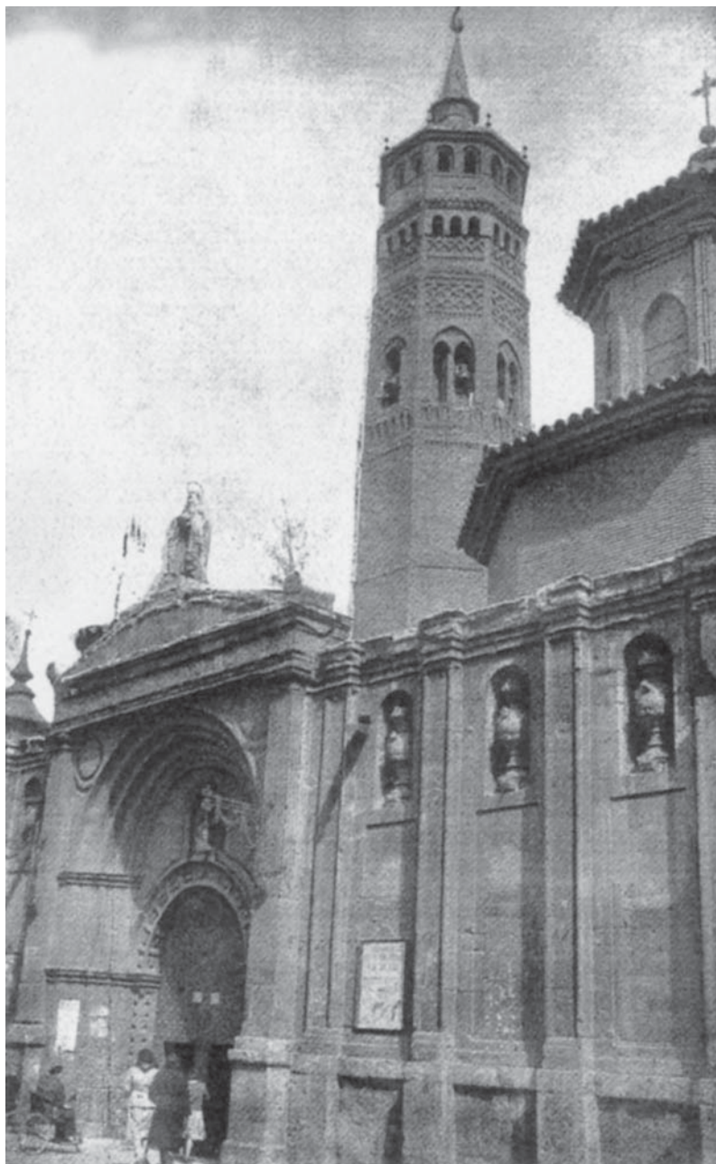
Iglesia parroquial de San Pablo (antes de la restauración).
