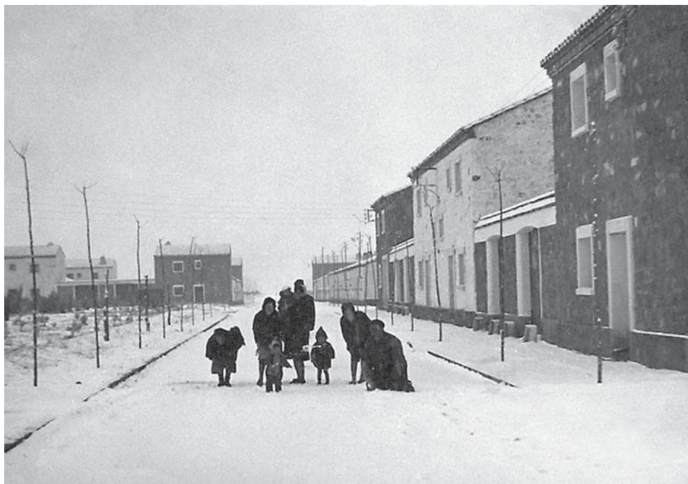
Bardenas nevada. En la década de 1980 se planteó la posibilidad de que, en la nueva zona regable, no se diesen los lotes en propiedad sino en usufructo.
