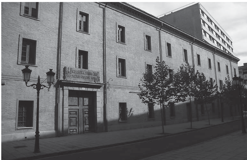
Figura 7: El antiguo Cuartel de Sangenis o Pontoneros en la actualidad, construido a finales del siglo XVIII por el arquitecto ilustrado zaragozano Agustín Sanz. (Foto Javier Martínez).
