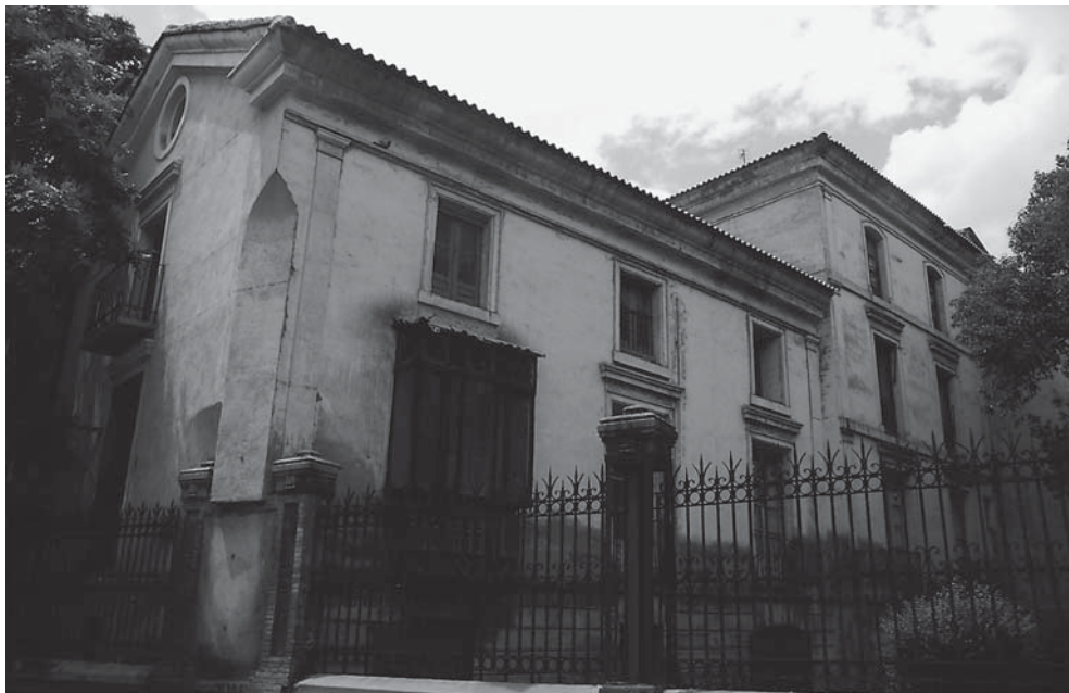
Figura 6: Antiguo Gobierno Militar, anteriormente Convento de Carmelitas Descalzas de San José y hoy centro administrativo municipal. Se ve la antigua y desconocida iglesia conventual de comienzos del siglo XVII, todavía conservada hoy pero sin restaurar pese a su indudable valor patrimonial (Foto Javier Martínez).
