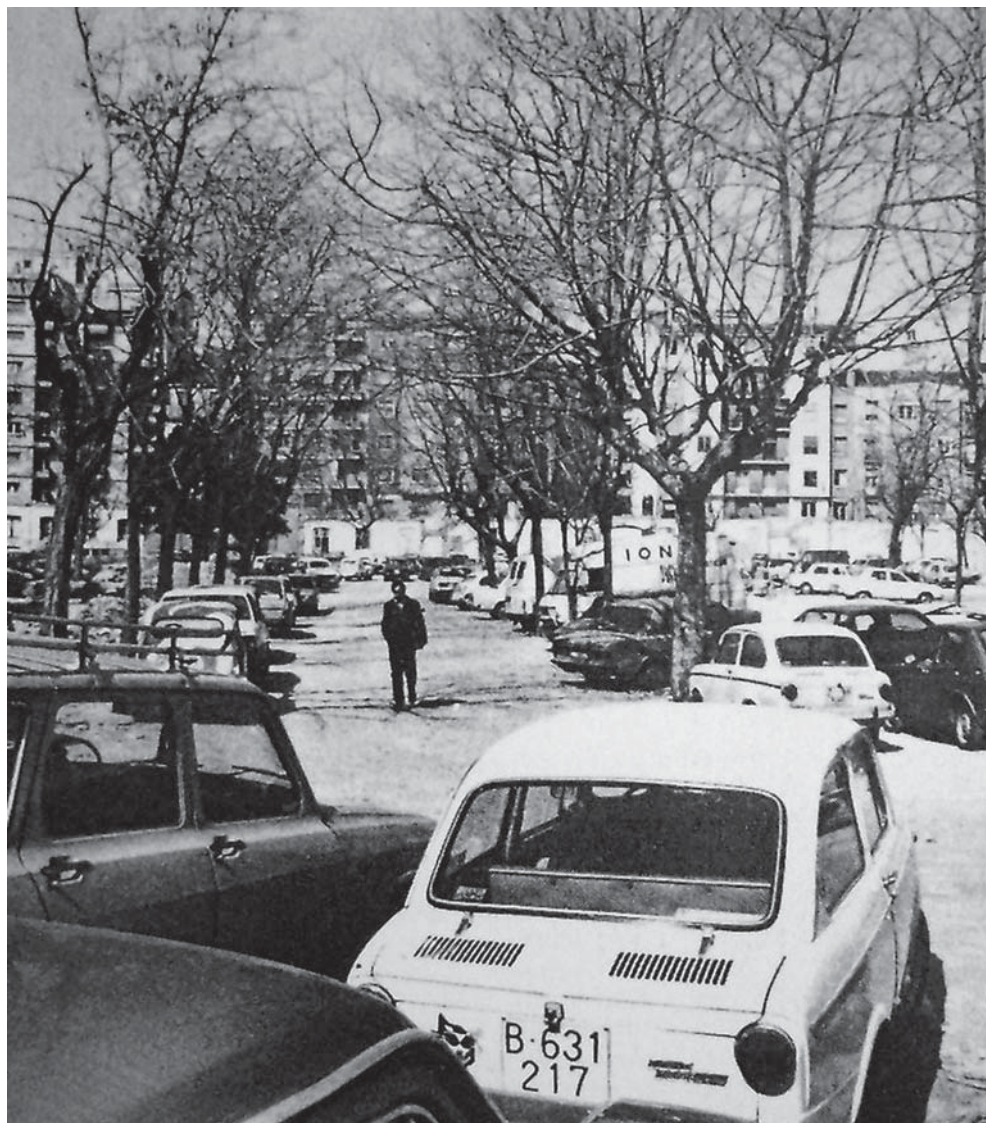
Figura 5: Solar del antiguo Cuartel de Hernán Cortés en 1984, tras ser derribado y antes de ser construida la Biblioteca de Aragón. Al fondo se ve la calle Hernán Cortés (Foto Nuestra Zaragoza ).
