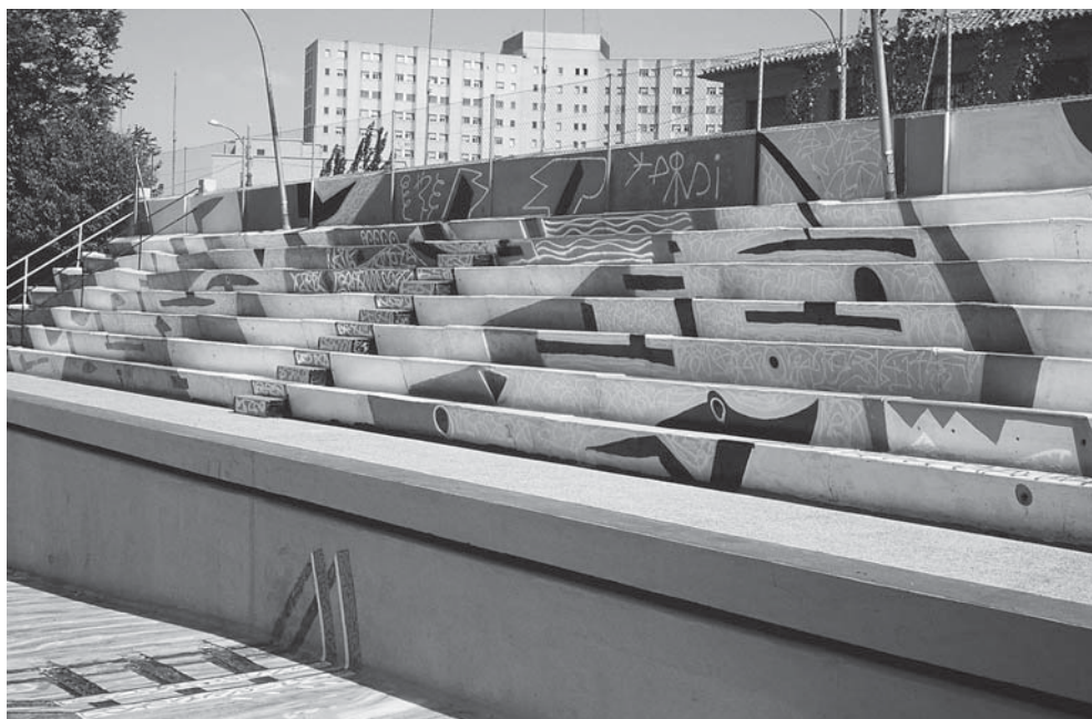
Figura 3: Pintura del graderío del Centro Deportivo Municipal Gran Vía (antigua Hípica).
